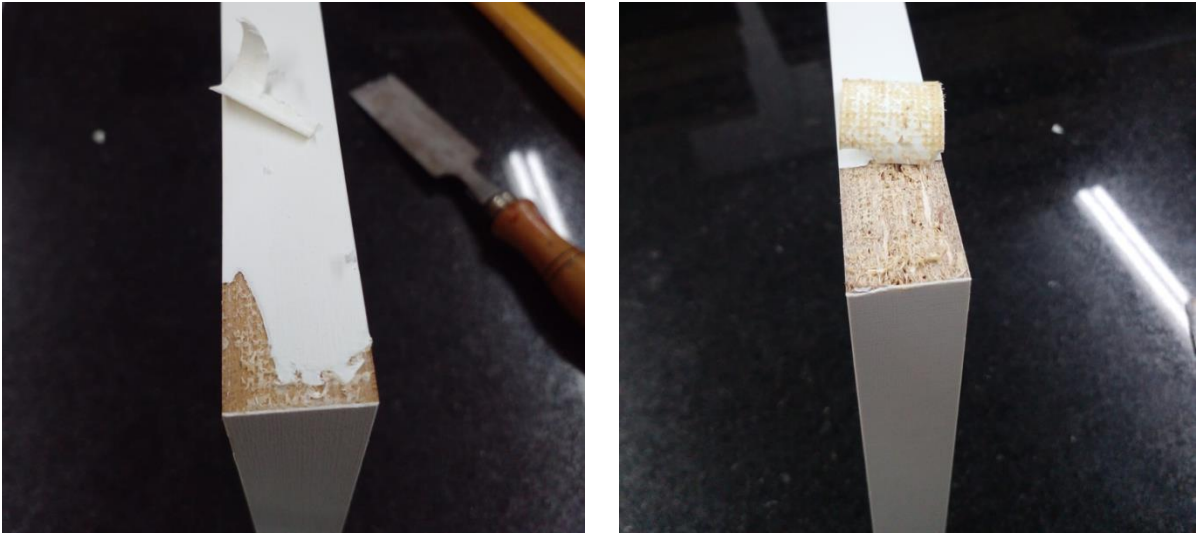
Figura 8. Representação das falhas da descolagem por delaminação
