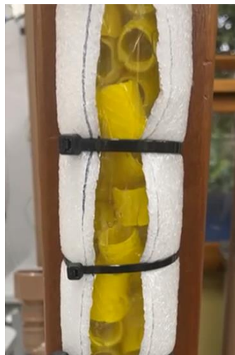
Figura 14 - Coluna da torre de resfriamento equipada com manta térmica e seção para observação da operação.
