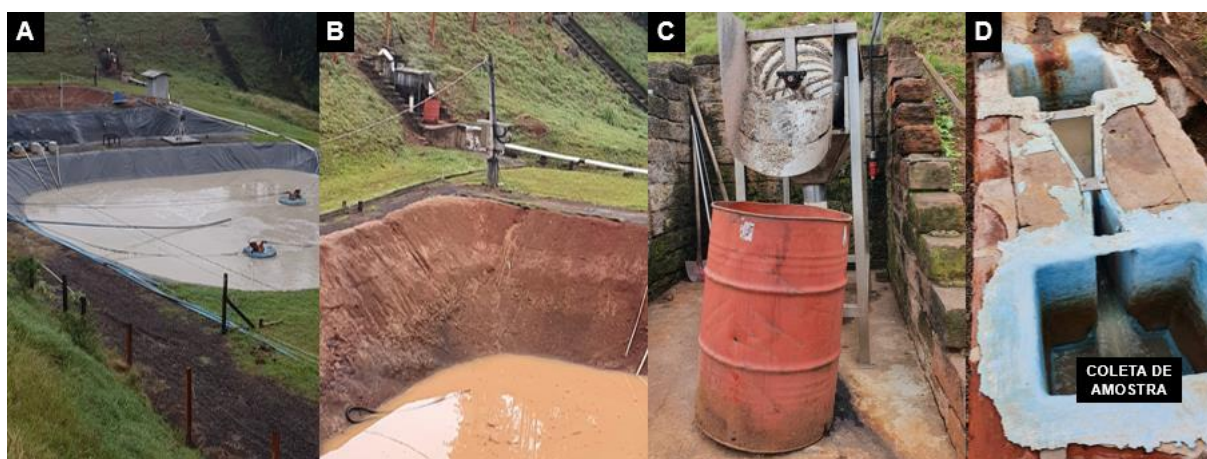
Figura 3 – Local da coleta do efluente orgânico, A) ETE da fábrica, B) Tanque de aeração, C) Peneira rotativa e D) Calha Parshall, local de coleta da amostra
