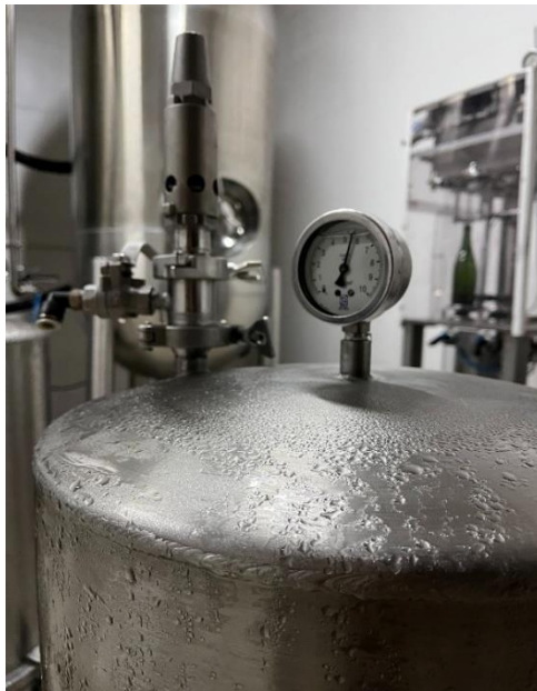
Figura 14: Pressão de filtração (5,5 atm.).
