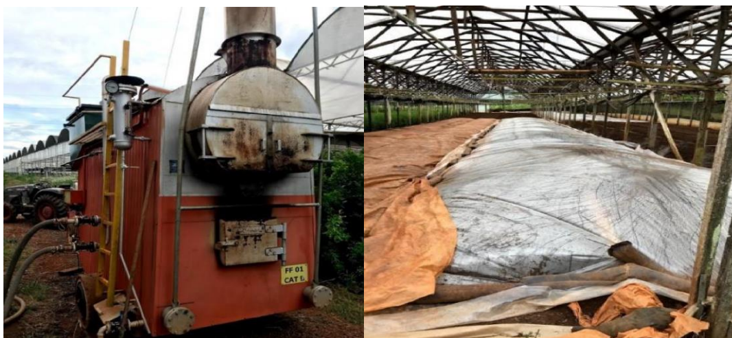
Figura 1: Caldeira no processo de esterilização.
