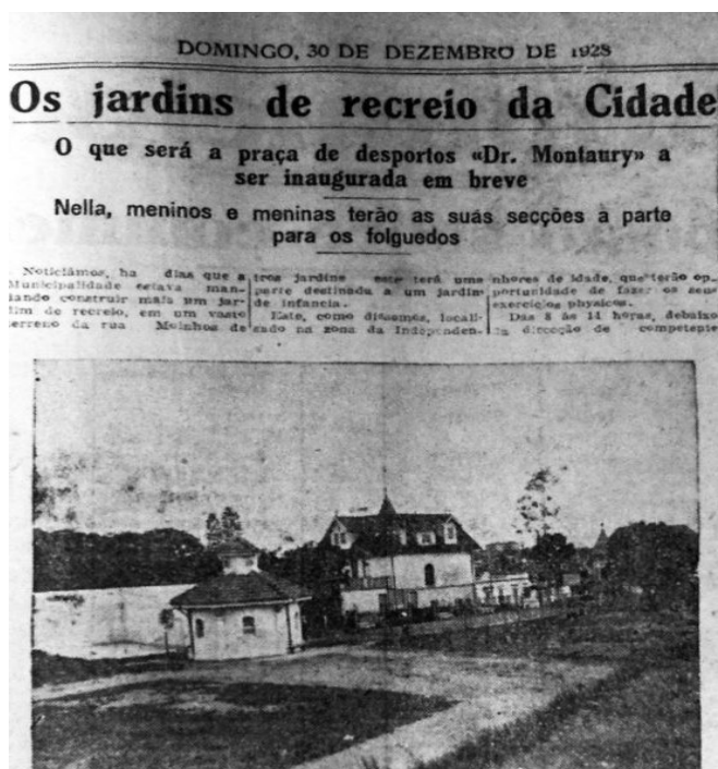
Figura 1 – Obras da praça de desportos Dr. Montaury Fonte: Jornal Correio do Povo, 30 de dezembro de 1928.
