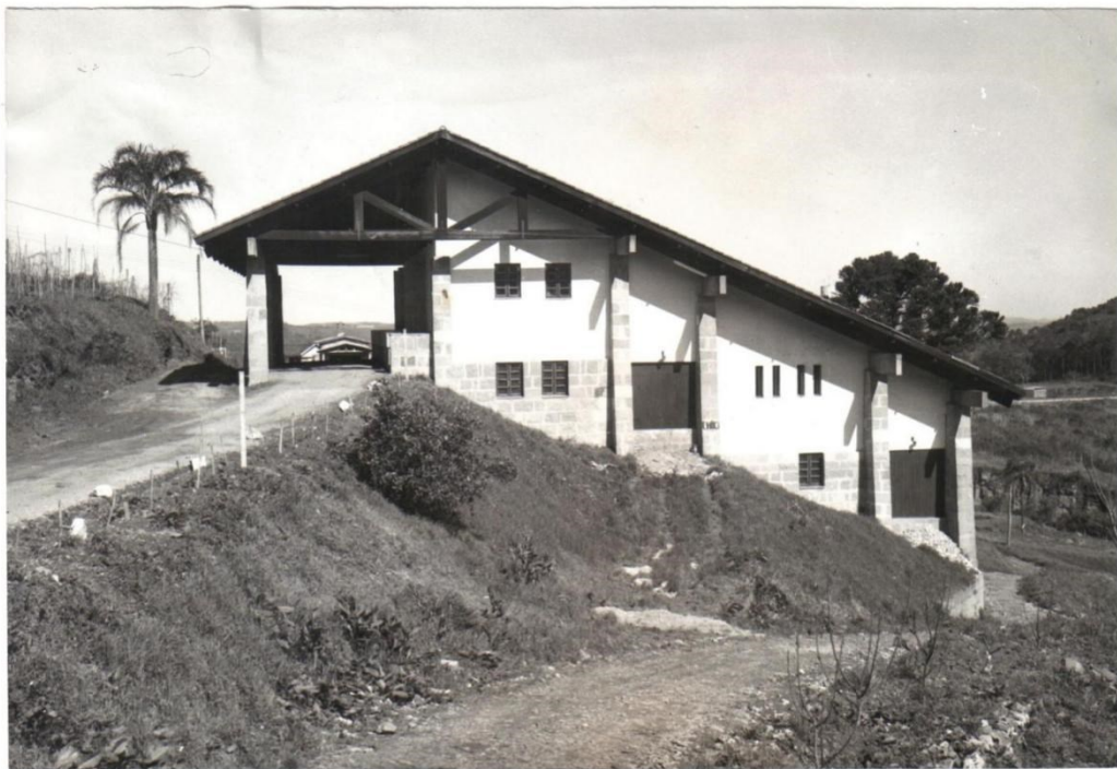
Figura 37 – Concluída a construção da Vinícola-Escola (1979)
