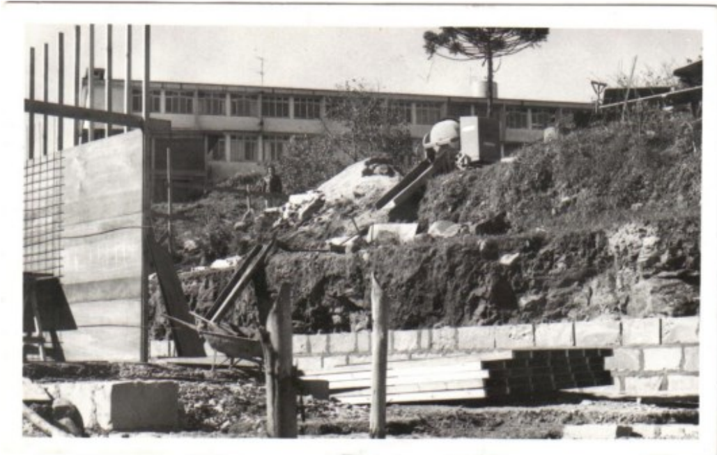
Figura 36 – Construção do prédio da Vinícola-Escola do Colégio de Viticultura e Enologia de Bento Gonçalves
