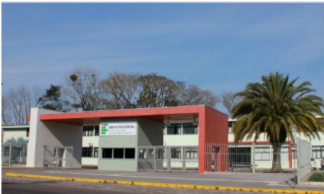
Figura 51 – Pórtico de acesso ao IFRS - Campus Bento Gonçalves
