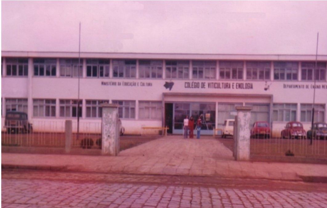
Figura 33 – Fachada do Colégio de Viticultura e Enologia
