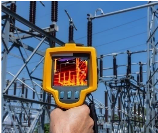
Figura 6 - Termômetro infravermelho realizando análise termográfica.
