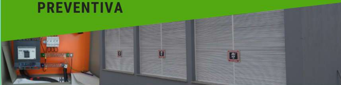
Construção da Subestação Campus Alvorada do IFRS, 2017
