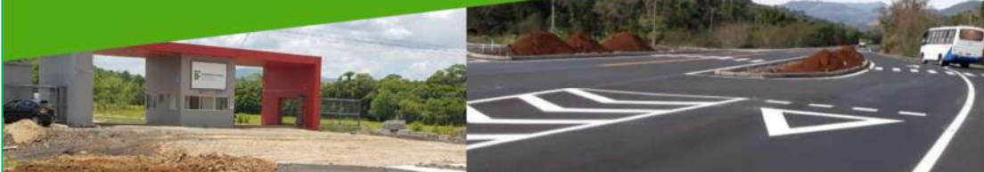
Construção do Acesso Campus Rolante do IFRS, 2018
