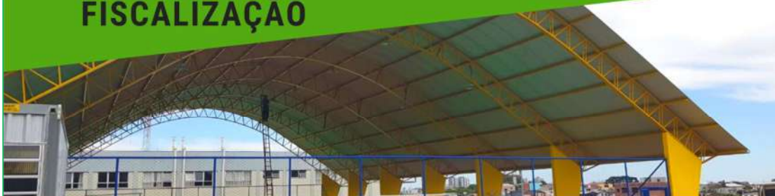
Construção da Quadra Poliesportiva Campus Caxias do Sul do IFRS, 2019
