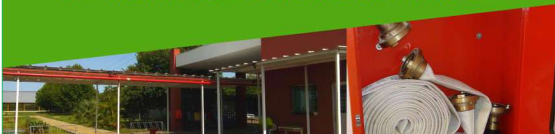
Construção do PPCI Campus Canoas do IFRS, 2019
