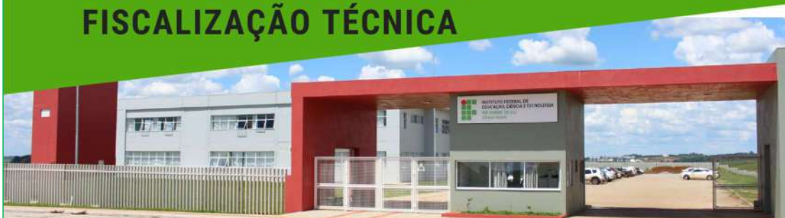
Construção do Pórtico do Campus Vacaria do IFRS, 2015
