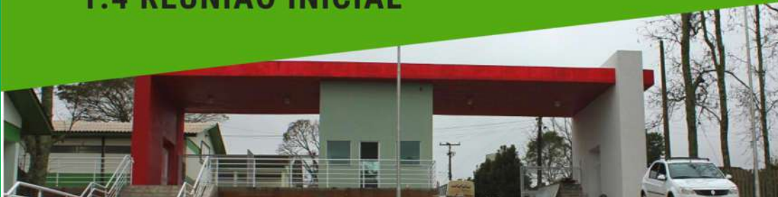
Construção do Pórtico Campus Ibirubá do IFRS, 2016
