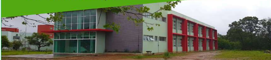
Construção do Bloco Acadêmico Campus Canoas do IFRS, 2017
