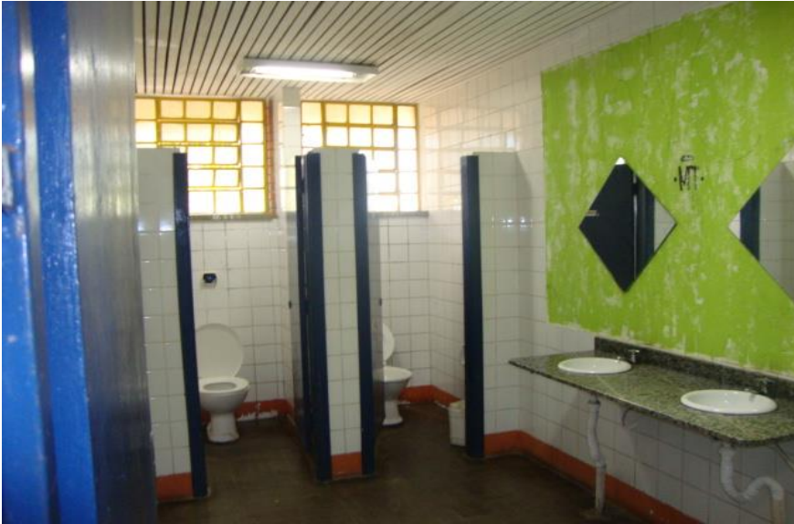
Figura 36. Banheiro da escola D Fonte: Autor, 2016
