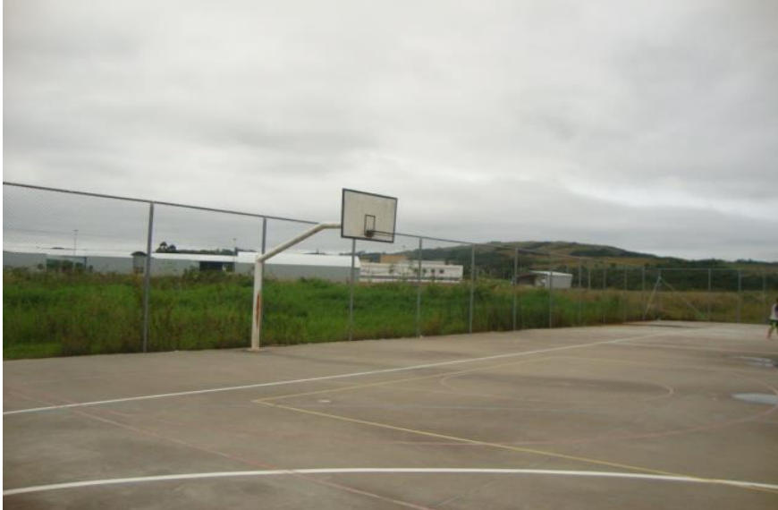
Figura 6. Quadra poliesportiva sem cobertura
