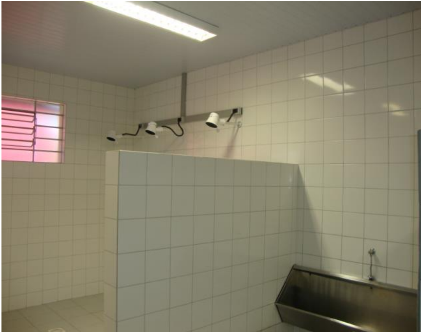
Figura 10. Banheiro e vestiário
