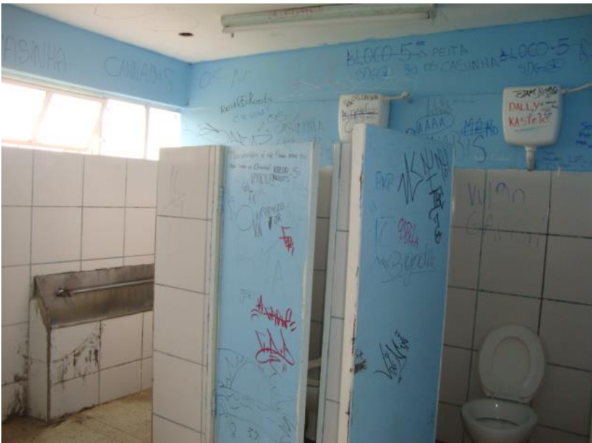
Figura 19. Banheiros Fonte: Autor, 2016
