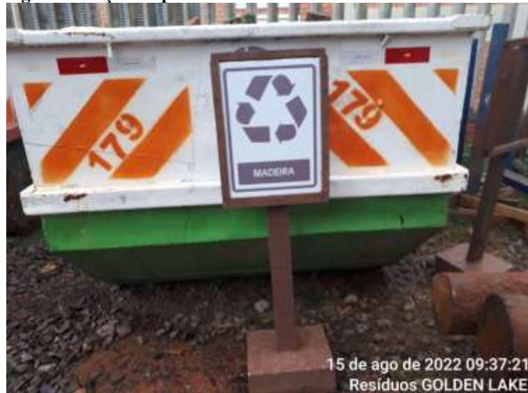
Figura 3. Caçamba para resíduos de madeira
