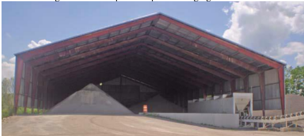
Figura 21 - Exemplo de depósito de agregados coberto
