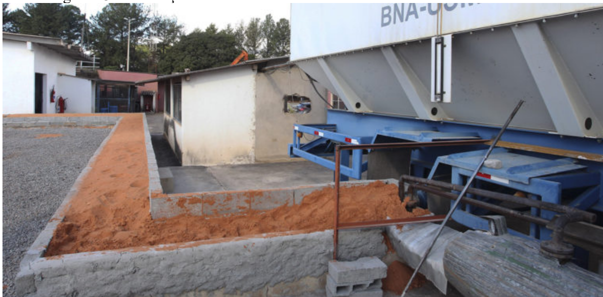
Figura 23 - Tubulação coberta com areia saibrosa melhora o isolamento térmico
