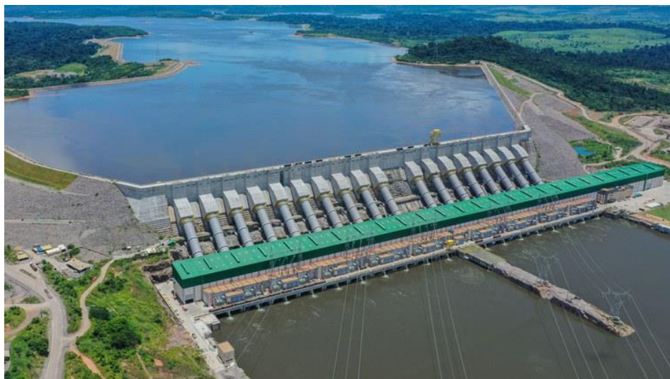
Figura 6 - Usina de Belo Monte (Fonte: IBAMA, 2021)
