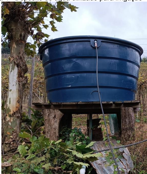
Figura 4 - Depósito de água utilizado para irrigação
