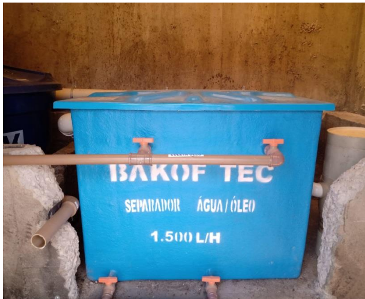
Figura 08- Caixa separadora água e óleo
