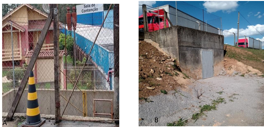
Figura 07- Espaço confinado e adequação
