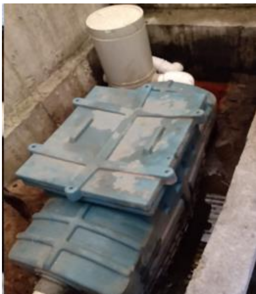
Figura 08- Caixa separadora água e óleo
