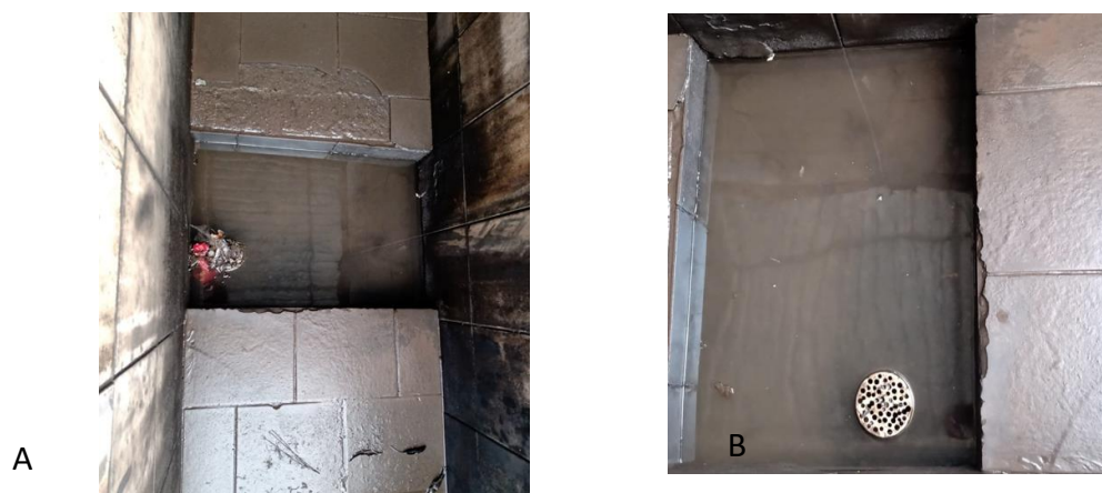
Figura 06- Rampa de troca de óleo na transportadora e lavagem
