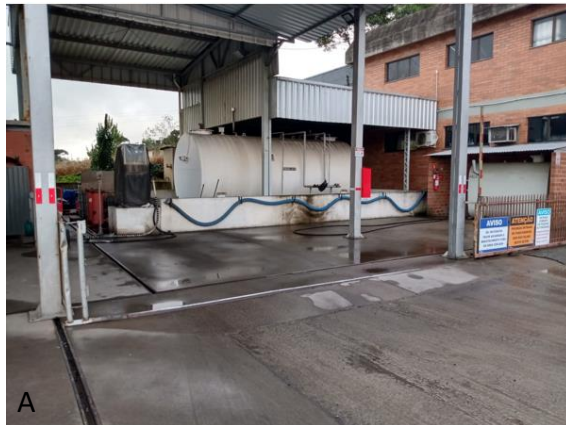
Figura 04- Canaletas e rampa de troca de óleo na
