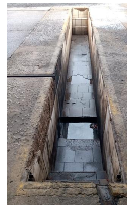
Figura 05- Rampa de troca de óleo na transportadora e lavagem
