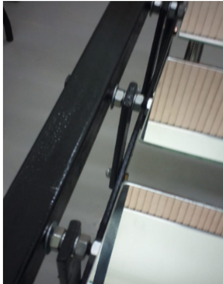
Figura 27 - Fixação do mecanismo de 4 barras nos eixos dos espelhos
