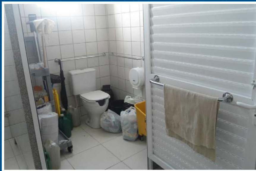
Figura 4: Sanitário PNE no Campus Caxias, em visita realizada em 01/12/2015. Fonte: GT Acessibilidade (2015)
