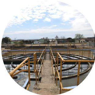
A remoção de partículas em suspensão (coagulação, decantação e filtração) é essencial no tratamento da água de reservatórios abertos e deve preceder a desinfecção, pois a presença de matéria orgânica em suspensão prejudica a ação do cloro, usado como desinfetante.
