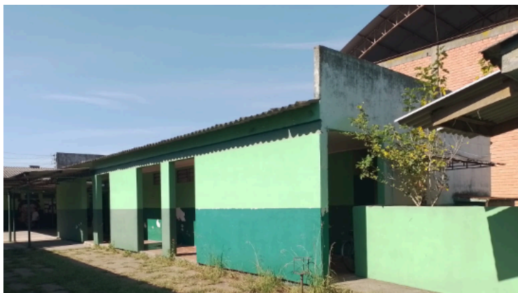
Figura 60 – Parede lateral do prédio do refeitório.
