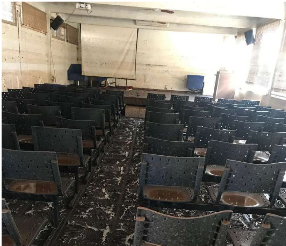
Figura 03 - Marcas da enchente deixadas na estrutura física da sala do auditório.
