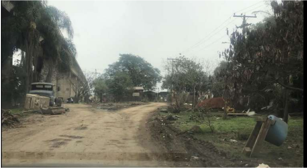
Figura 1 – Consequência da força das águas embaixo da 4ª ponte, na Ilha das Flores.
