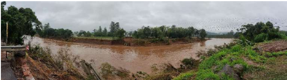
Figura 1 – Foto panorâmica do local da ponte levada pela enchente do Rio Caí.
