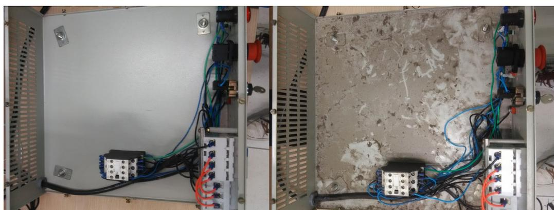
*Figura 9 Painel de Alimentação e Proteção - Aberto*
