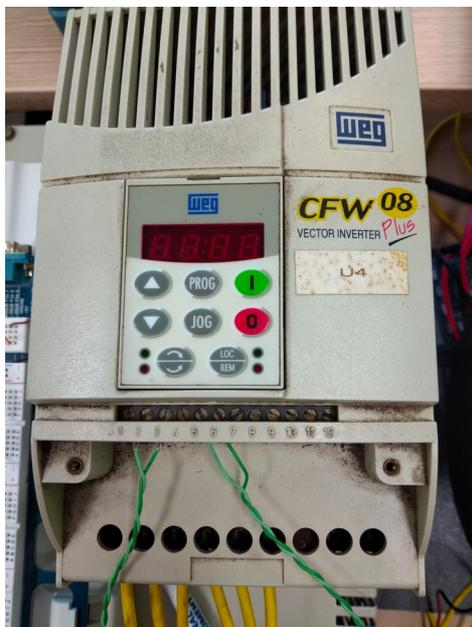
*Figura 11 Inversor de frequência*
