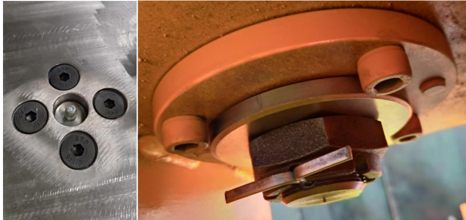
Figura 56 - Detalhe do travamento do sistema giratório
