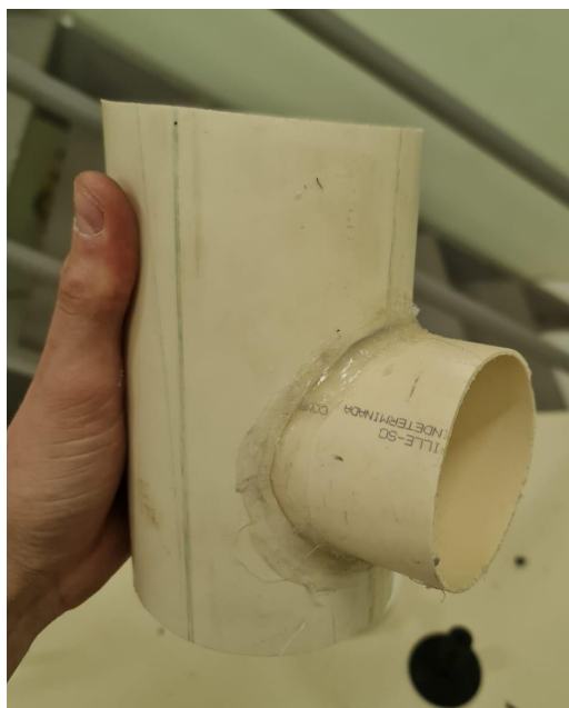
Figura 24 - Início da montagem.
