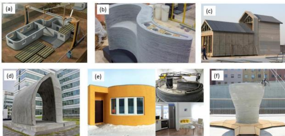
Figura 2 – Exemplos de impressão em concreto do tipo counter crafting (a), trabalho da universidade de Loughborough (b); impressão pelas empresas Winsun (c) e Xtree (d); impressão de residência em Apis-cor na França (e); e projeto denominado mini-builder na Espanha (f).
